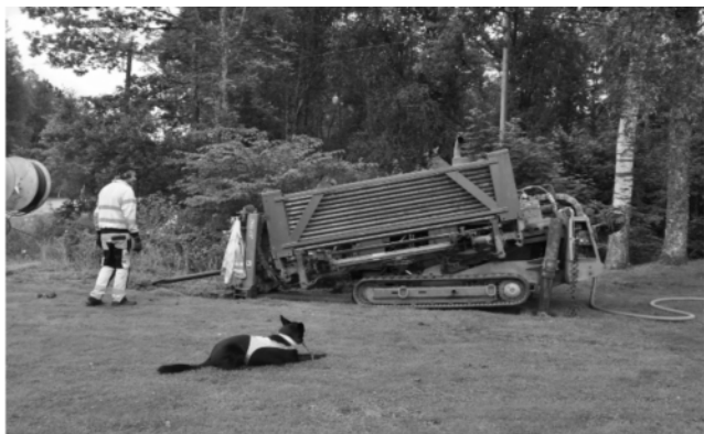
Micke och fiberhunden övervakar arbetet med bormaskinen.
