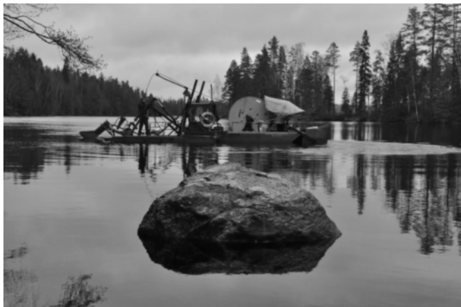
Sjökabel förläggs med specialbyggd båt
